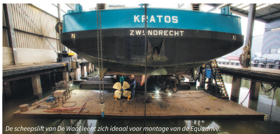
Montage door de specialisten van Verhaar en De Waal. De stroomkabels worden met snelsluitingen vastgeklit.
