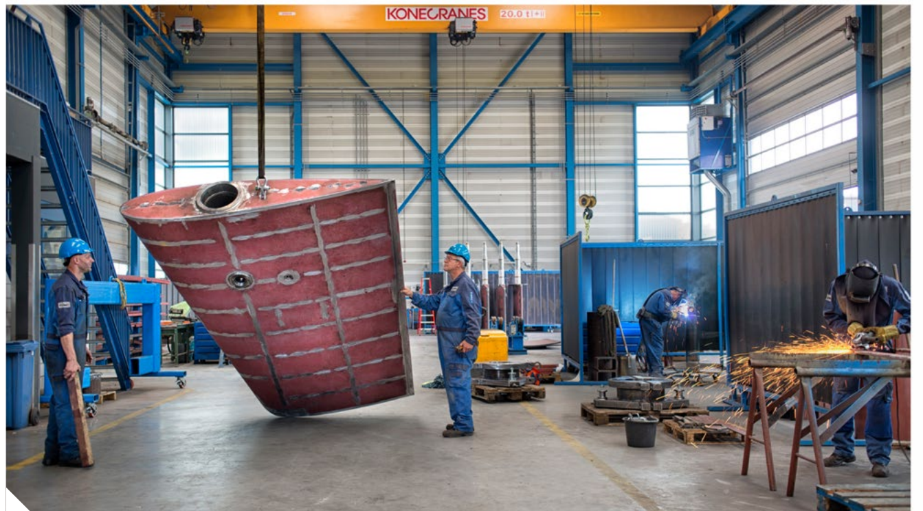
Alle typen scheepstroeren worden bij De Waal gebouwd in de 15 meter hoge constructiehal. Deze is bestemd voor een 110 meter superjacht.
